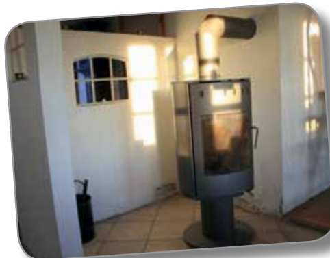
Der er brændeovn i bindingsværkshuset.
